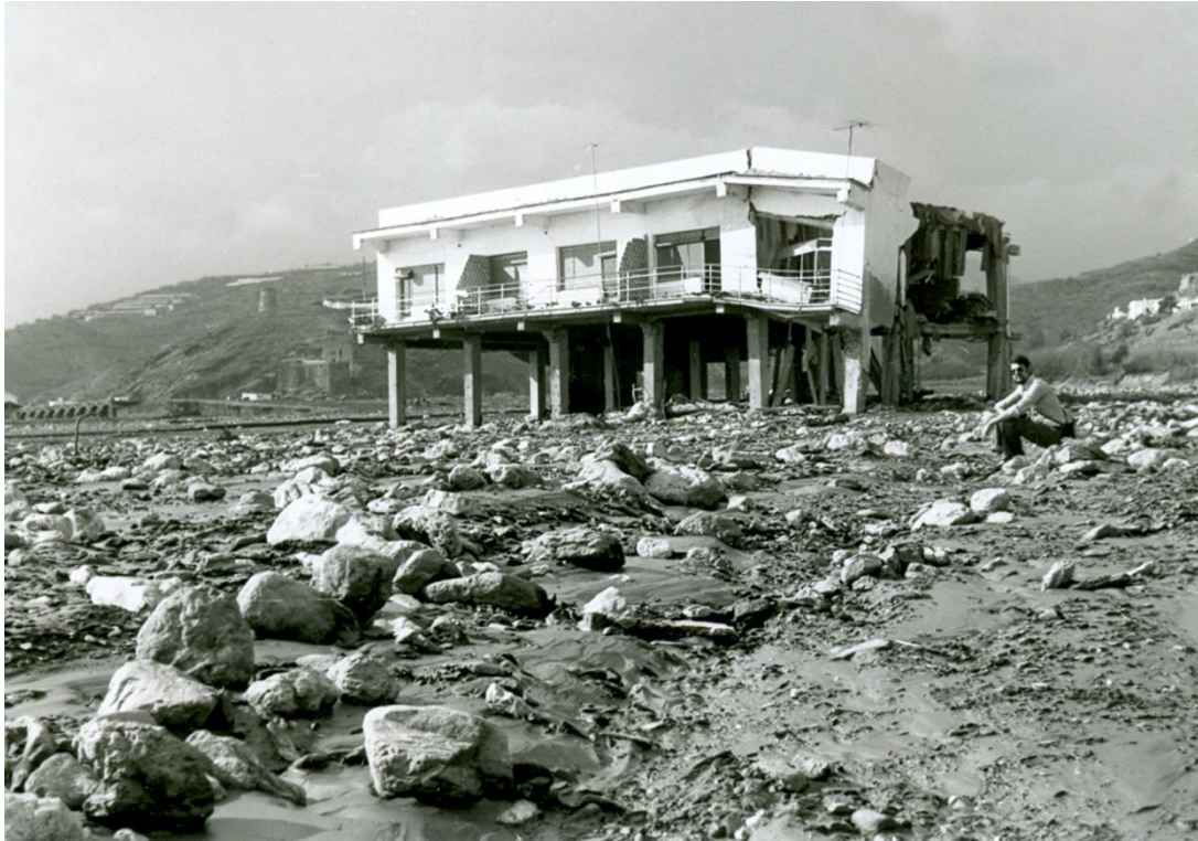
Un edificio arrasado por un caudal de agua, barro y piedras que alcanzó registros excepcionales. Foto Evaristo Martínez. Archivo Ángel García Peramos.
